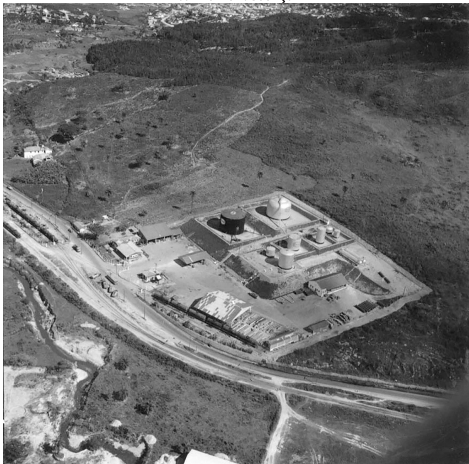
Figura 5: Vista aérea dos depósitos da Esso na década de 1950. À esquerda a sede da Fazenda Cachoeirinha e na porção superior parte do bairro Renascença.
